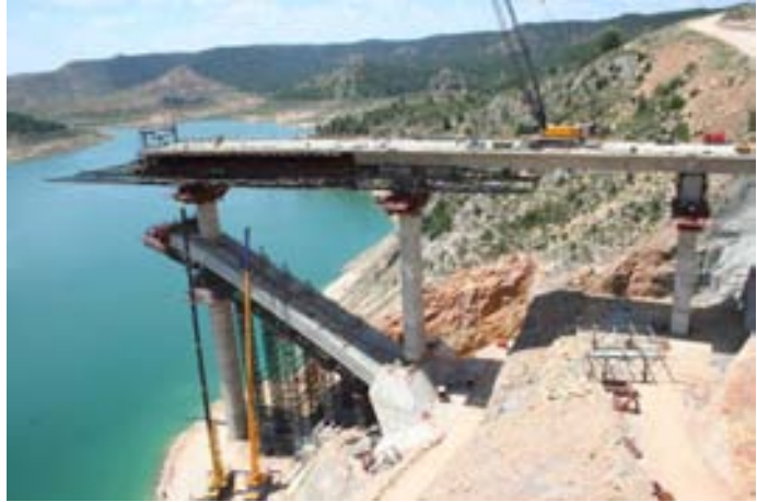
Fig 8. Primer tramo de arco apeado
