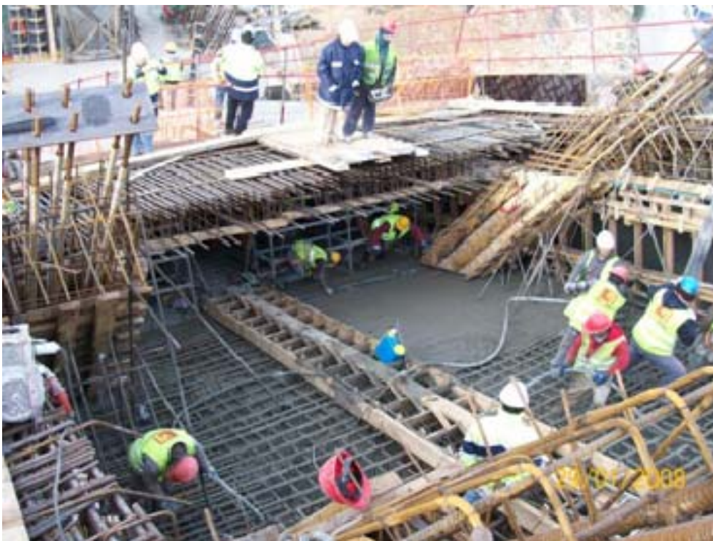
Fig 4. Hormigonado de una sección del arco cimbrado
