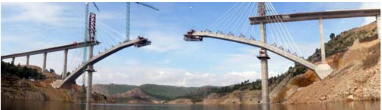
Fig 12. Vista general del viaducto en construcción
