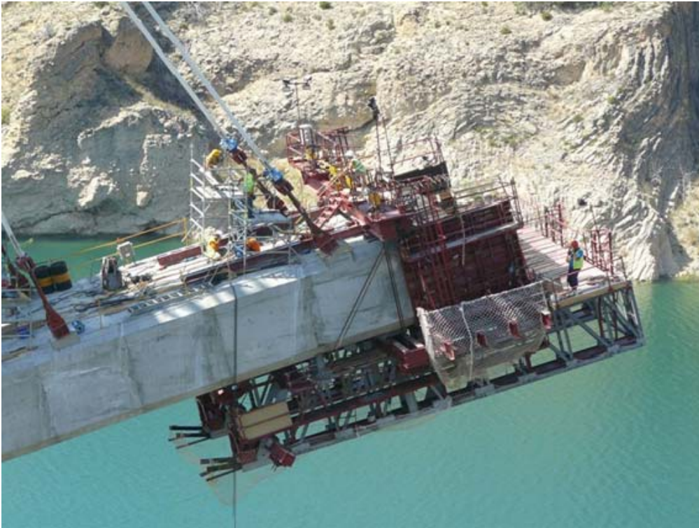
Fig 2. Carro de hormigonado del lado Cuenca
