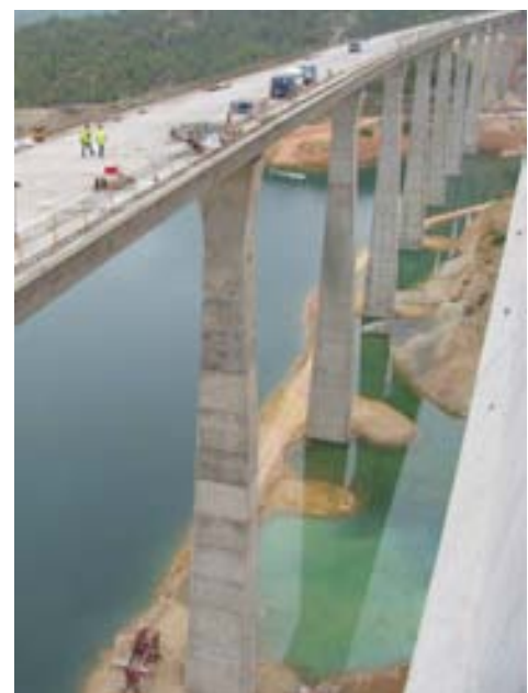
Fig 5 Pilas de vanos de acceso
