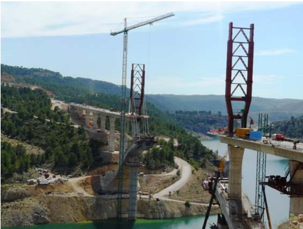
Fig 5. Vista de las obras del Viaducto sobre el Embalse de Contreras desde el lado Valencia
