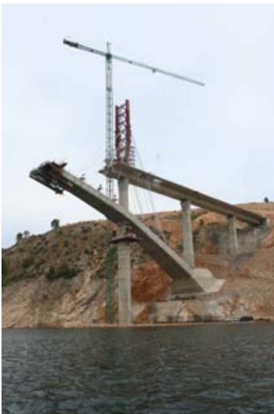
Fig 9. Atirantamiento provisional
