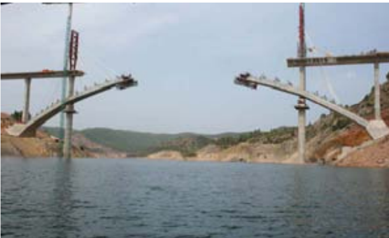
Fig 7 Construcción del arco
