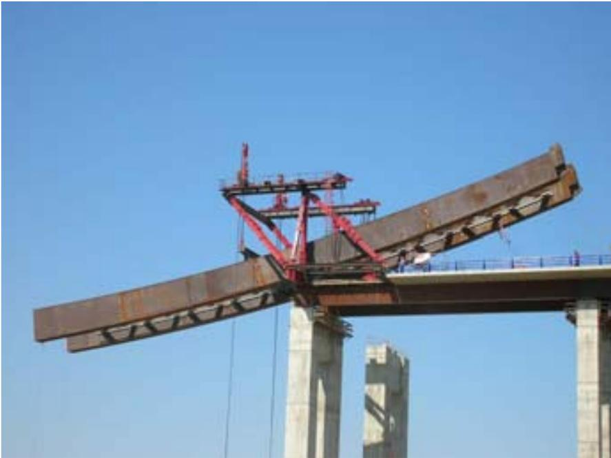
*Fig. 15 Pórtico para primer basculamiento*
