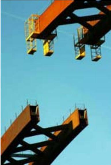
Fig. 26. Extremo frontal de semiarcos en posición previa al cierre en clave
