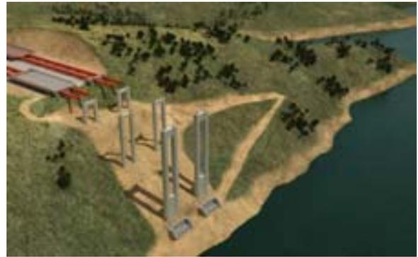
*Fig. 3 Construcción de tableros completos en tierra firme*
