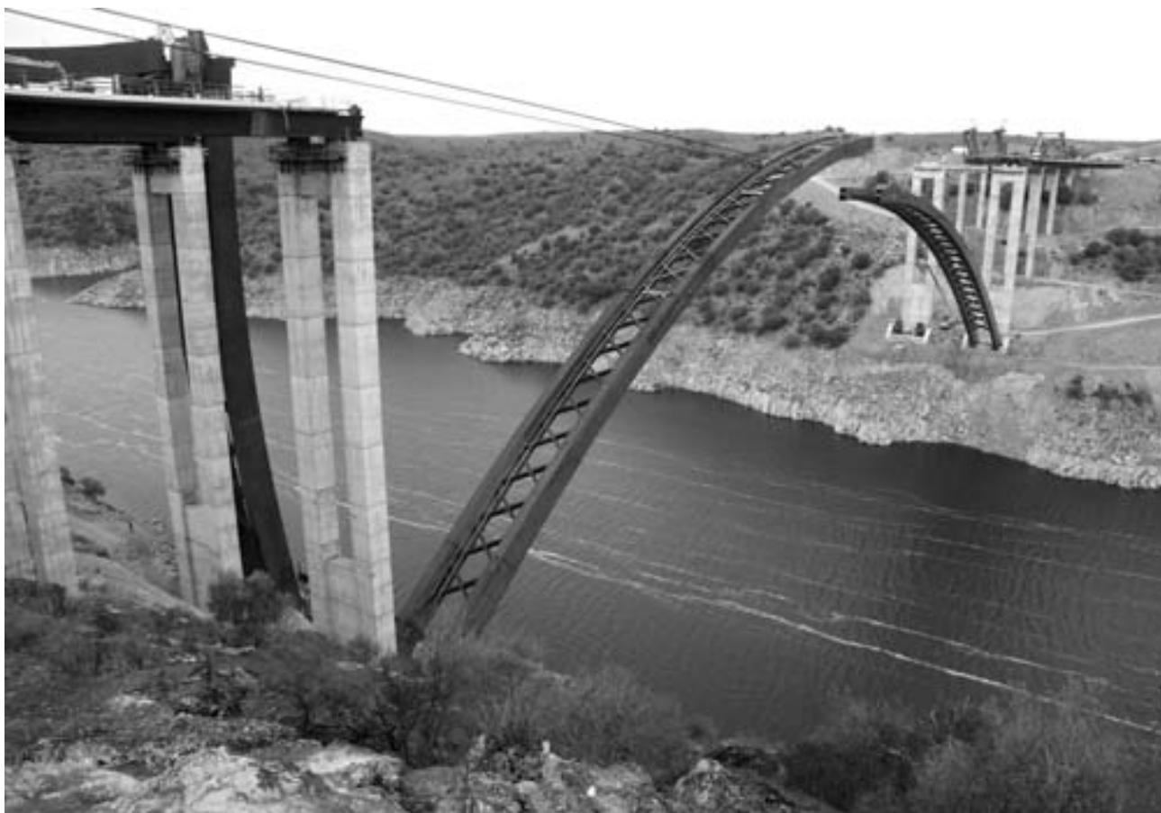
Figura 1. Situación constructiva cuando se produjo el primer fenómeno de resonancia.
