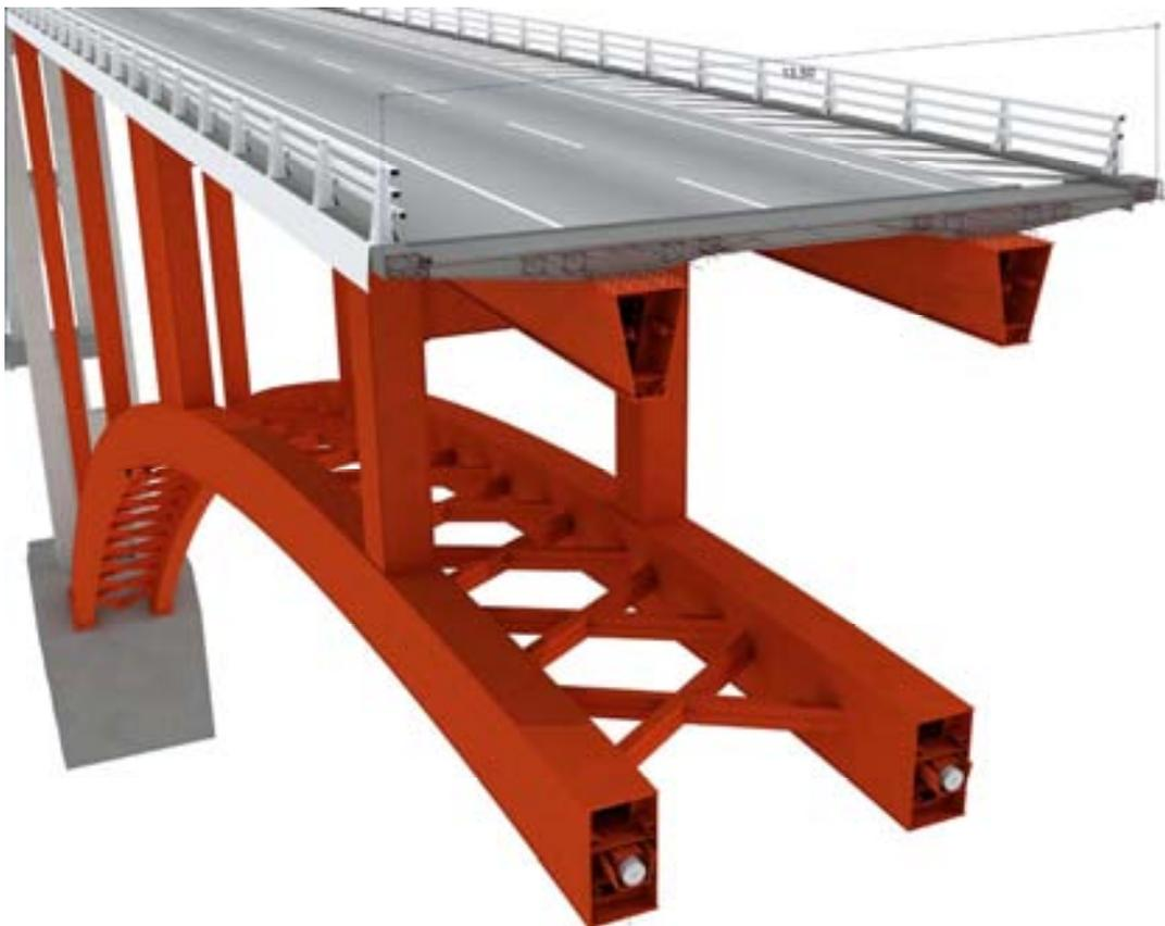
El cruce del Embalse se realiza mediante un tramo formado por un arco de tablero superior.
