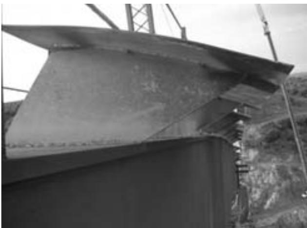
Figura 4. Deflectores instalados.
