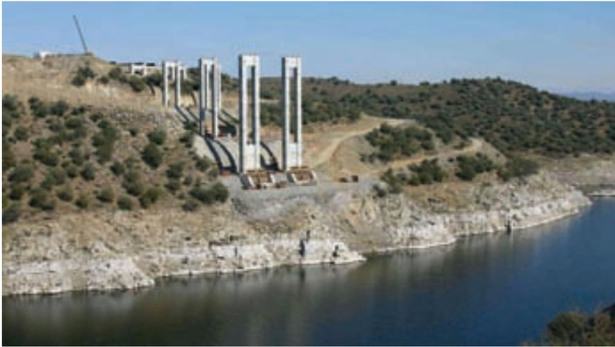
Figura 14. Construcción de macizos de arranque de arcos, pilas de hormigón y estribos.
