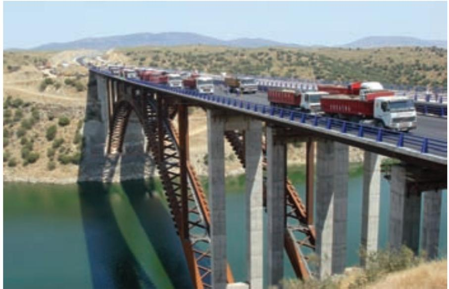
Figura 62. Prueba de carga.
