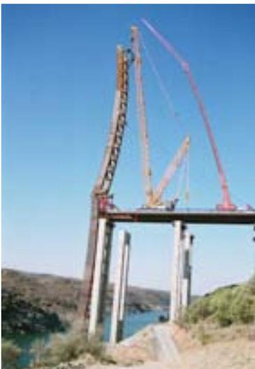
*Fig. 21 Posición final de la maniobra de izado con grúa*
