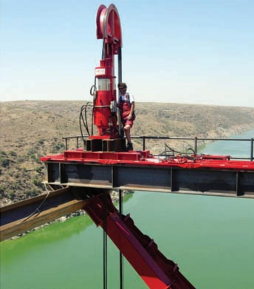
Figura 21. Pórtico de basculamiento. Detalle de un gato hidráulico.
