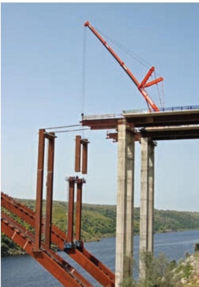
Figura 39. Montaje de pilas metálicas con grúa sobre tablero.
