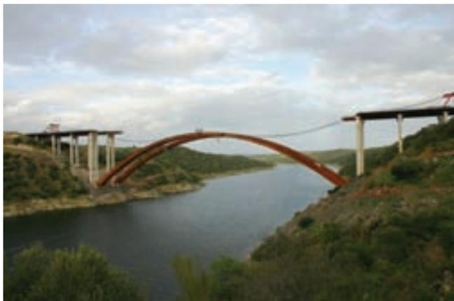
Figura 38. Cierre en clave de arco del segundo puente.
