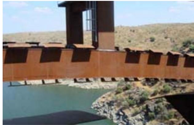
Fig. 5. Deflectores instalados
