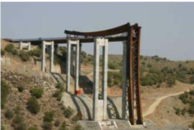
*Fig. 19 Segundo cuarto de arco conectado en una zona provista de rótulas*
