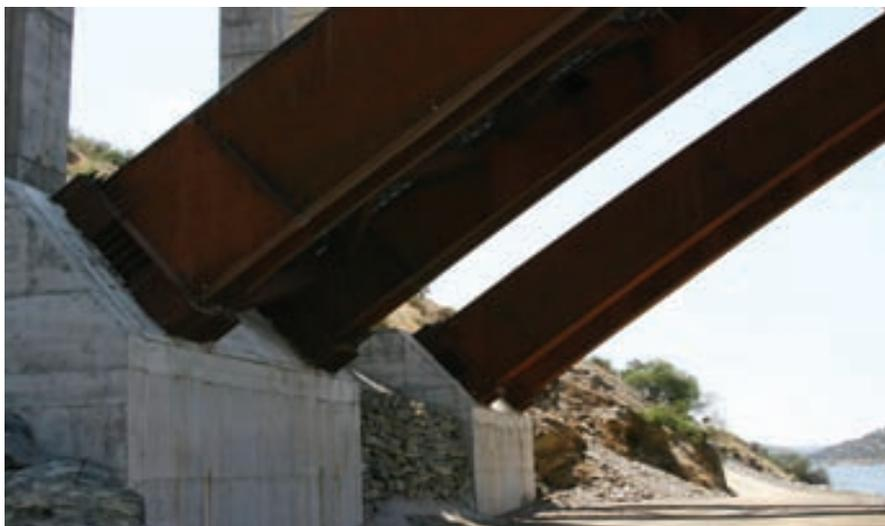
Figura 10. Empotramiento del arco.
