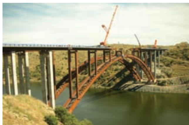
Figura 42. Empuje de tablero sobre arco (3).
