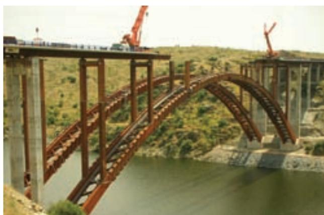
Figura 41. Empuje de tablero sobre arco (2).
