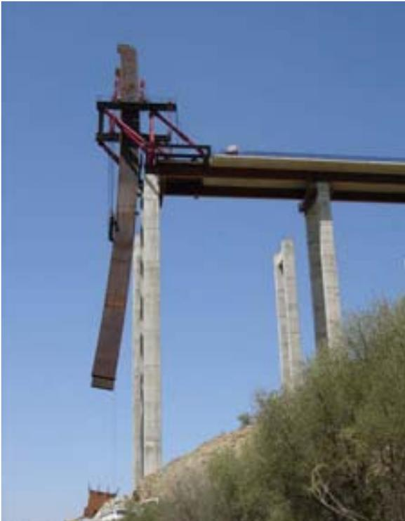
*Fig. 18 Descenso de cuarto de arco y ensamble con pieza inferior en la base del arco*
