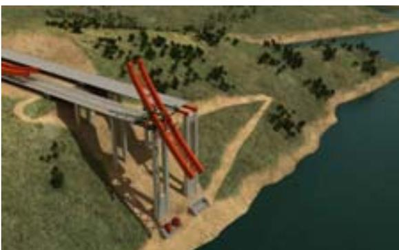
*Fig. 6 Basculamiento del primer cuarto de arco y descenso en posición vertical*
