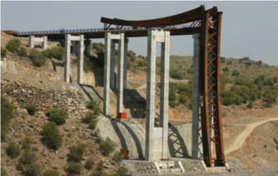
Figura 23. Segundo cuarto de arco conectado en una zona provista de rótulas.
