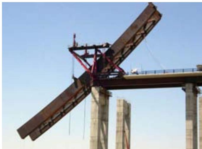
*Fig. 17 Primer basculamiento de cuarto de arco*
