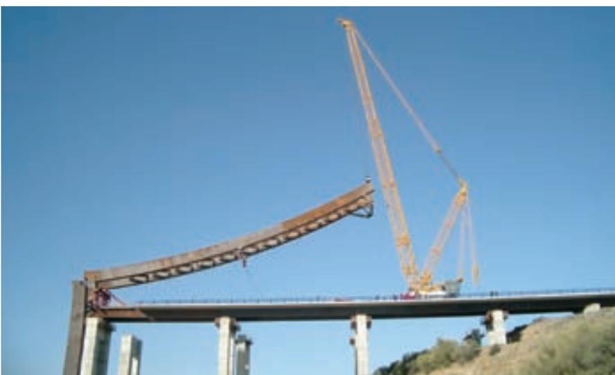
Figura 25. Izado de segundo cuarto de arco con grúa.
