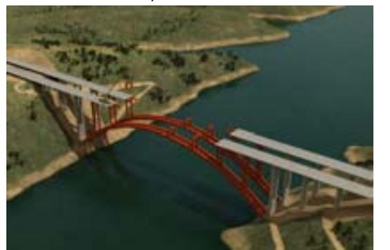
*Fig. 13 Colocación de pilas metálicas sobre el arco*
