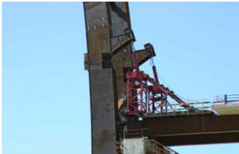
*Fig. 22 Posición final de basculamiento del segundo cuarto de arco, mediante accionamiento de gatos situados en la estructura auxiliar*
