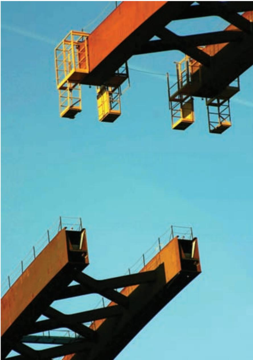
Figura 51. Extremo frontal de semiarcos en posición previa al cierre en clave.
