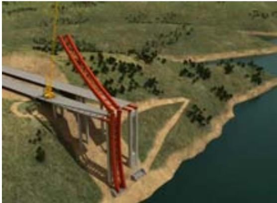
*Fig. 8 Basculamiento del segundo cuarto de arco con ayuda de una grúa situada sobre el tablero*
