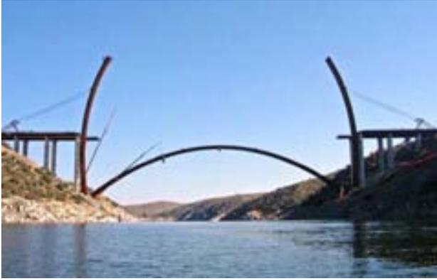
Fig. 1. Estado de la construcción al producirse las vibraciones
