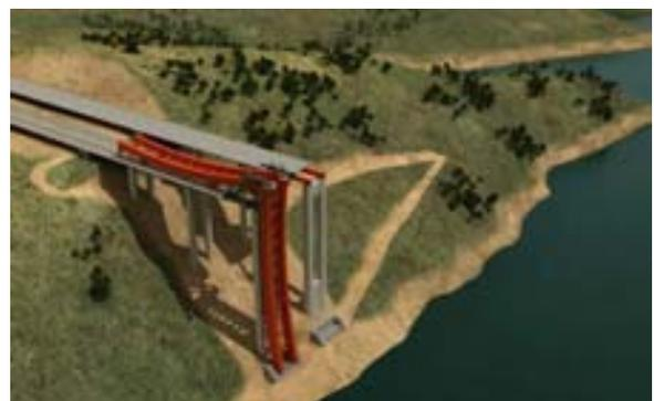
*Fig. 7 Ensamblaje del extremo inferior con la pieza de soporte del arco y montaje del segundo cuarto de arco sobre el tablero y unión con el primero en una zona provista de rótula*
