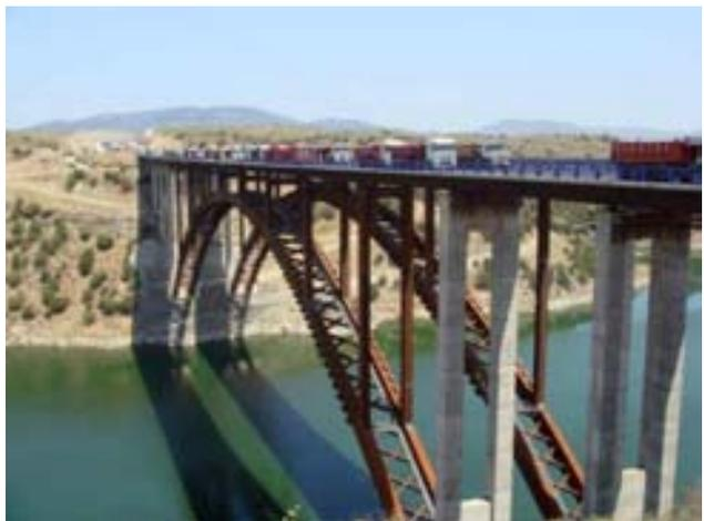
*Fig. 28 Obra terminada. Prueba de carga realizada el 15 de julio de 2006*
