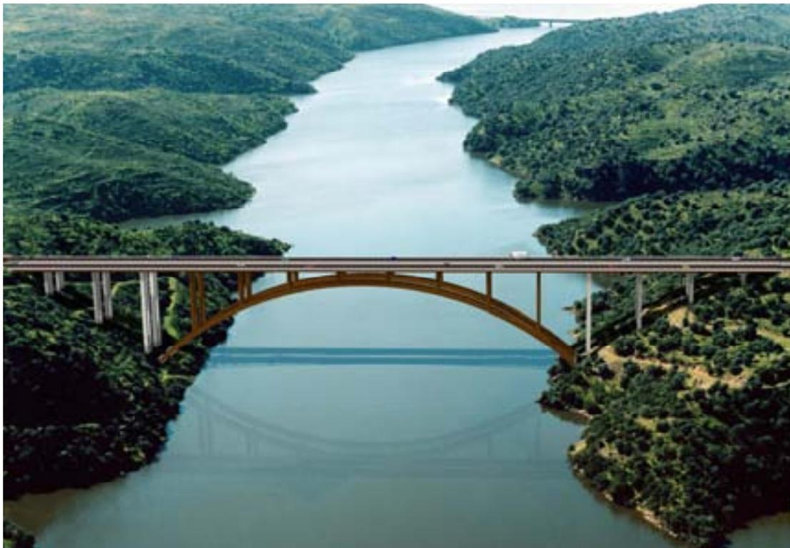
Cada uno de los arcos está formado por dos piezas longitudinales con sección de cajón, arriostradas entre sí.
