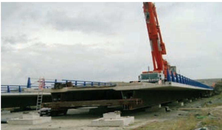
Figura 16. Empuje de un tablero. En la parte trasera, viga metálica transversal de empuje.
