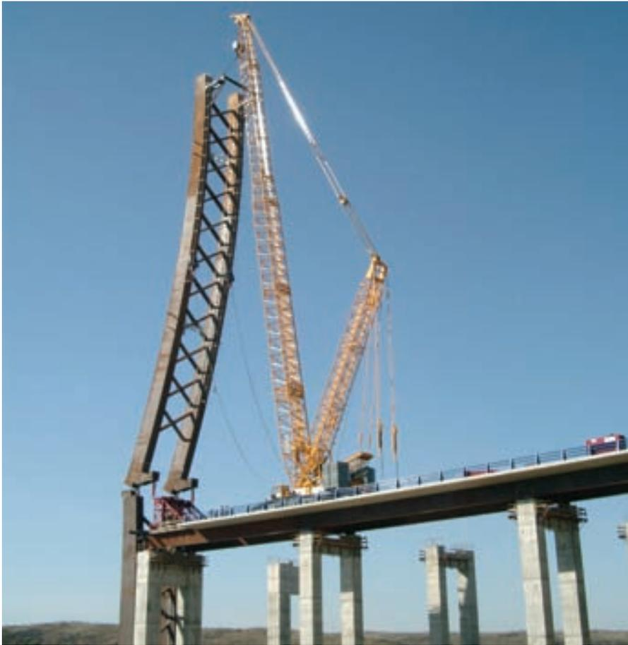
Figura 26. Posición final de izado de tablero con grúa.
