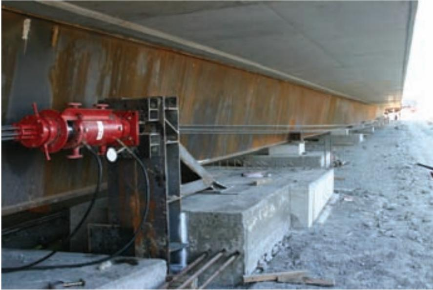
Figura 17. Gato y cable de tracción
