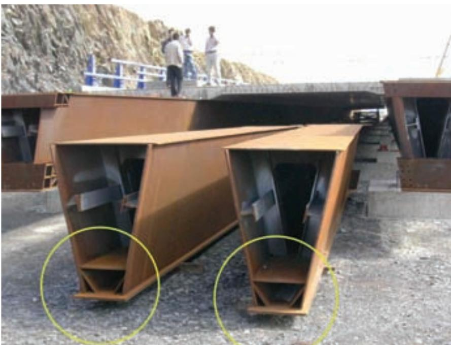
Figura 6. Tablero. Vigas – cajón metálicas. Rigidez en la parte inferior, apropiada para la situación de apoyo durante el empuje del tablero
