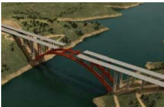
*Fig. 14 Fases varias de empuje de tablero y colocación de pilas sobre el arco*
