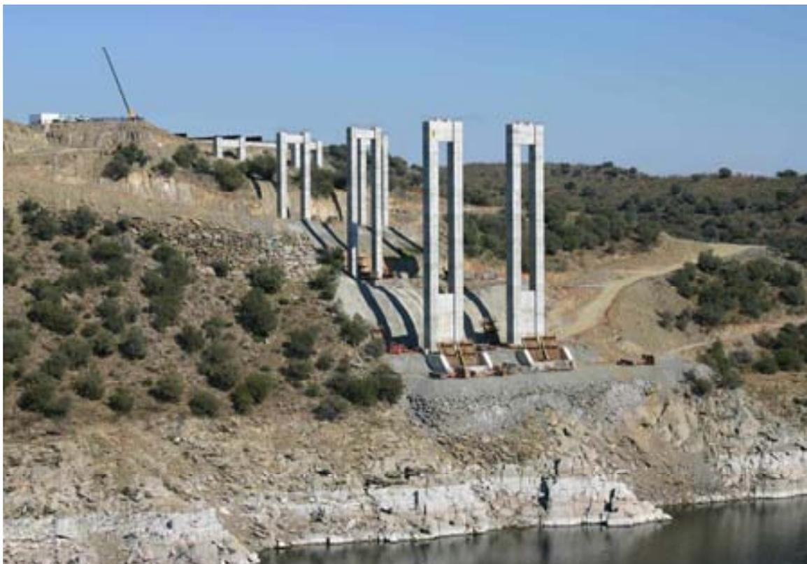
Las pilas más altas situadas en la proximidad del embalse tienen una altura de 52 metros y disponen en su parte superior de un sistema destinado a proporcionar una coacción transversal al tablero frente a la acción del viento y que permite al mismo tiempo, el libre desplazamiento del tablero en dirección longitudinal.
