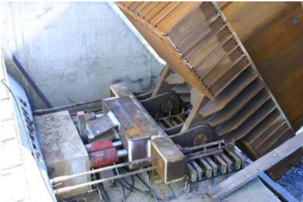
Fig. 24 Zona inferior del arco en la en la situación posterior al abatimiento de semiarcos
