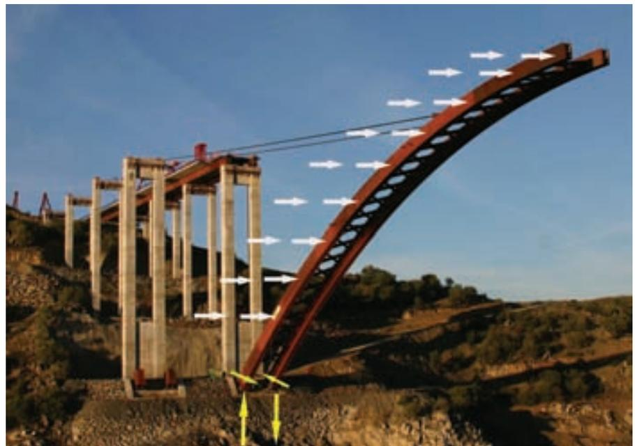
Figura 50. Efecto del viento lateral sobre un semiarco durante la maniobra de abatimiento.
