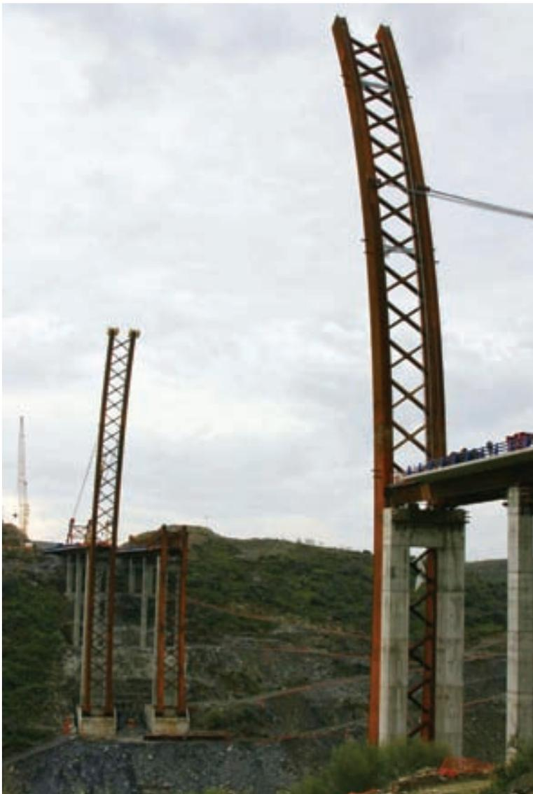
Figura 29. Semiarcos en posición vertical. Altura: 120 metros.
