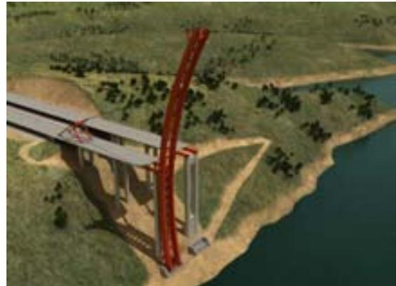
*Fig. 9 Fin del basculamiento hasta completar la posición vertical del semiarco. Montaje de estructura de retenida para abatimiento de semiarco*
