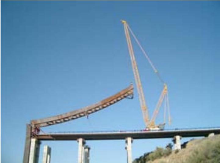
*Fig.20 Izado de segundo cuarto de arco con grúa*
