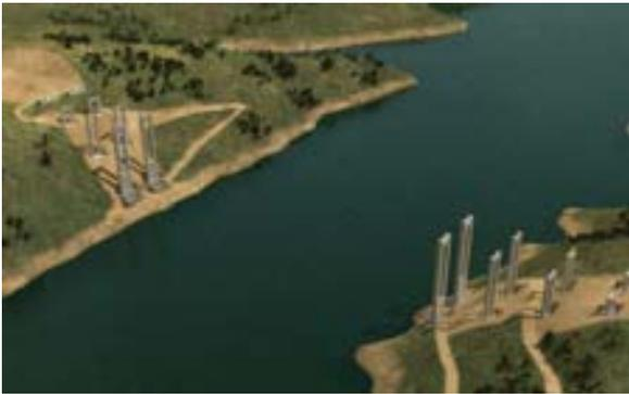
*Fig. 2 Construcción de la infraestructura: Cimentaciones, pilas, estribos y macizos de arranque de arcos*
